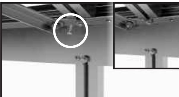
Fahren Sie mit der Regenrinne und den Dachstreben fort. Verschrauben Sie die Regenrinne und die Dachstreben mit der Bohrschraube 4,8x13 mm.
