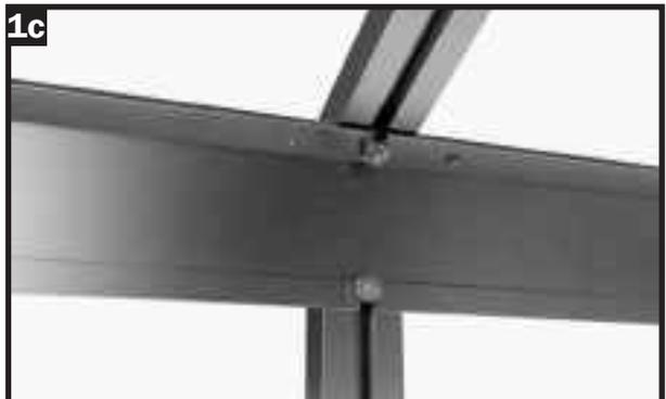
Verschrauben Sie die Dachstrebe mit einer Flanschnutter M6 fest mit der Regenrinne.
