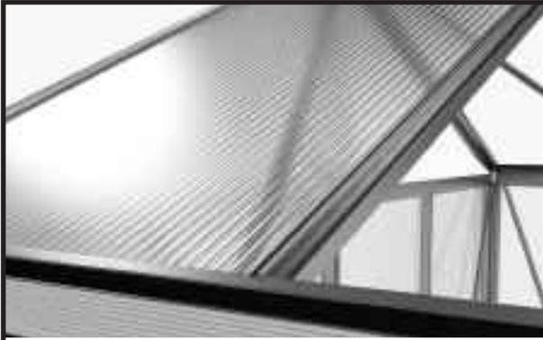
Fügen Sie die Dachplatten- bzw. Platten unter den Dachfenstern in die Felder der Dachflächen ein.
