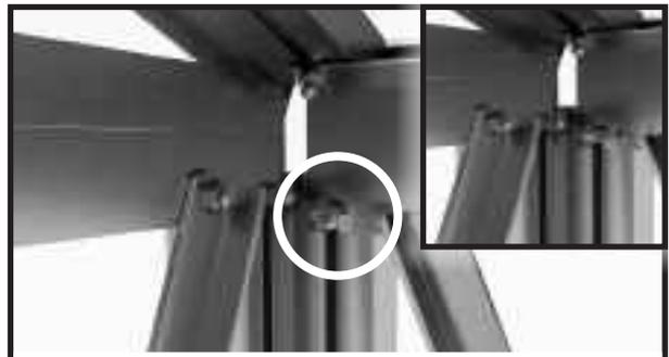
Fahren Sie mit der Regenrinne und dem Seiteneckprofile fort. Verschrauben Sie das Seiteneckprofil und die Regenrinne mit der Bohrschraube 4,8x13 mm.
