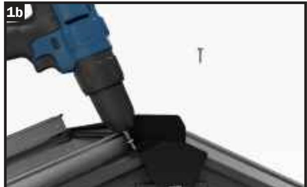
Befestigen Sie die Abdeckkappe mit den Bohrschrauben 4,8x13 mm am First.
