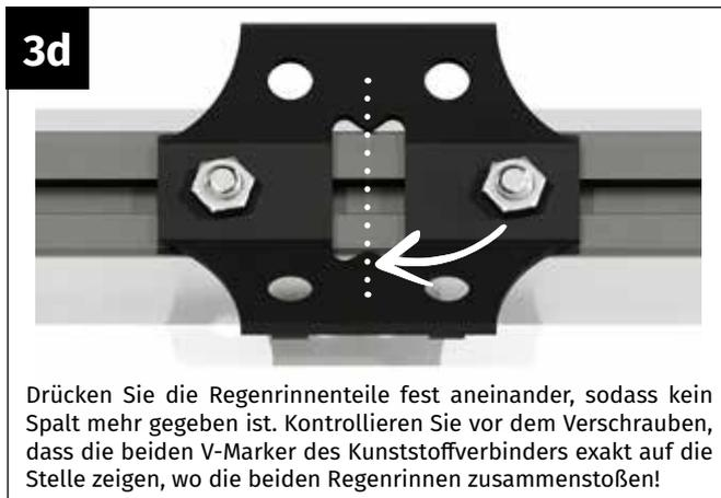
Drücken Sie die Regenrinnenteile fest aneinander, sodass kein Spalt mehr gegeben ist. Kontrollieren Sie vor dem Verschrauben, dass die beiden V-Marker des Kunststoffverbinders exakt auf die Stelle zeigen, wo die beiden Regenrinnen zusammenstoßen!
