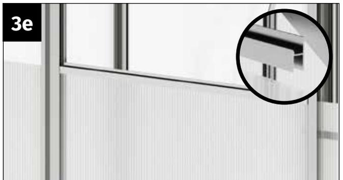
Setzen Sie ein H-Profil auf jede der beiden Stegplatten der Frontwand auf. **Siehe dazu auch obiges Detail zum Aufsetzen der H-Profile!**
