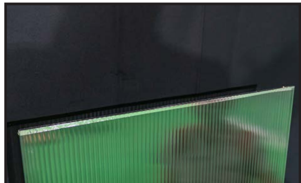
Streichen Sie das Klebeband gut auf den Stegplatten fest.
