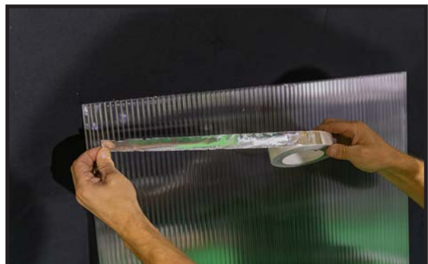
Bereiten Sie die Doppelstegplatten für den Einbau vor.
