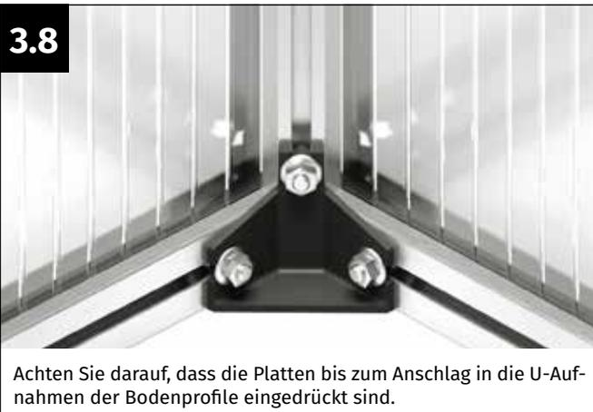
Achten Sie darauf, dass die Platten bis zum Anschlag in die U-Aufnahmen der Bodenprofile eingedrückt sind.
