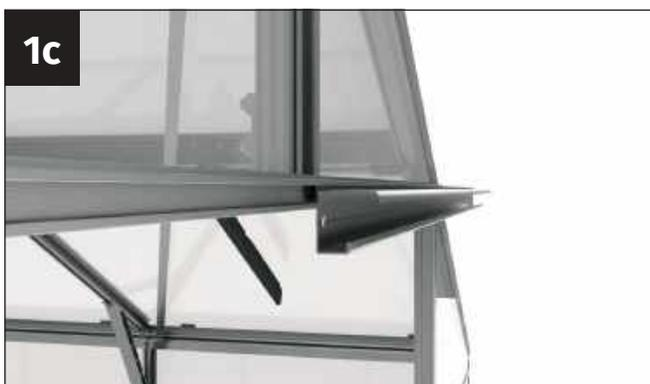
1c Führen Sie die Türlaufschiene bis zur Mitte der Türöffnung in das Querprofil ein.
