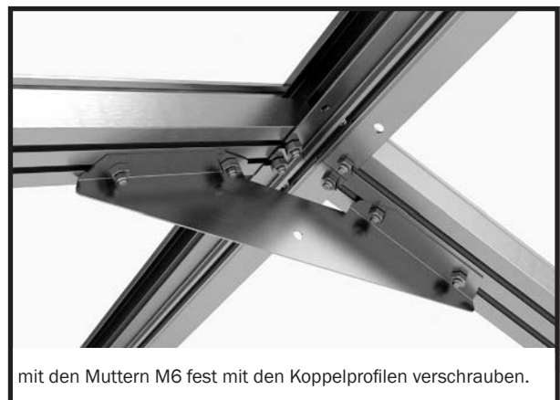
Verschrauben Sie das Knotenblech mit den Flanschmutter fest mit den Koppelprofilen.
