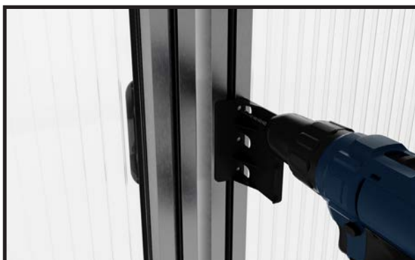
Montieren Sie nun die inneren Türgriffe. Bohren Sie Löcher mit einem 4 mm Bohrer.
