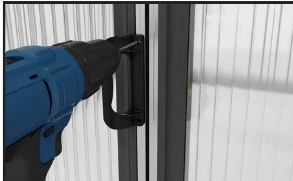
Beginnen Sie mit den äußeren Türgriffen. Bohren Sie Löcher mit einem 4 mm Bohrer.
