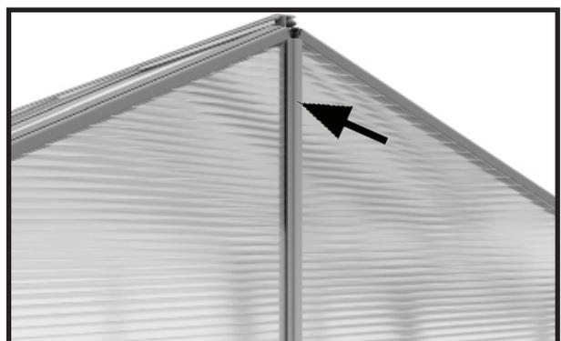
Kürzen Sie einen Kunststoffclip auf die Länge der Giebelstütze und drücken Sie diesen fest auf die Strebe, bis er einrastet.
