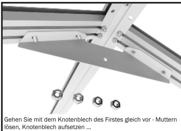
Gehen Sie mit dem Knotenblech des Firstes gleich vor - Muttern lösen, Knotenblech aufsetzen ...
