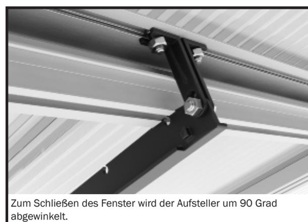
Zum Schließen des Fenster wird der Aufsteller um 90 Grad abgewinkelt.
