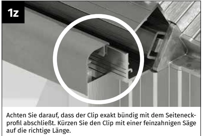
1z Achten Sie darauf, dass der Clip exakt bündig mit dem Seiteneckprofil abschließt. Kürzen Sie den Clip mit einer feinzahnigen Säge auf die richtige Länge.
