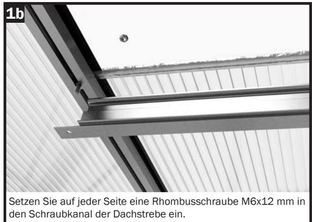
Setzen Sie auf jeder Seite eine Rhombusschraube M6x12 mm in den Schraubkanal der Dachstrebe ein.
