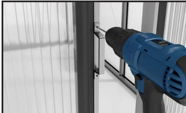
Bohren Sie Löcher mit einem 4 mm Bohrer.
