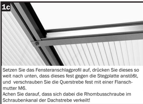
Setzen Sie das Fensteranschlagprofil auf, drücken Sie dieses so weit nach unten, dass dieses fest gegen die Stegplatte anstößt, und verschrauben Sie die Querstrebe fest mit einer Flanschmutter M6.
