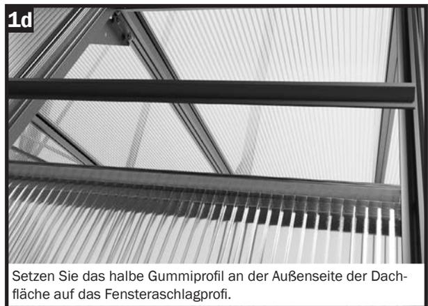
Setzen Sie das halbe Gummiprofil an der Außenseite der Dachfläche auf das Fensteranschlagprofil.
